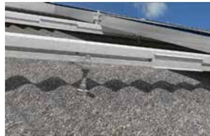
Dettaglio: vite STSI con staffa SSP
